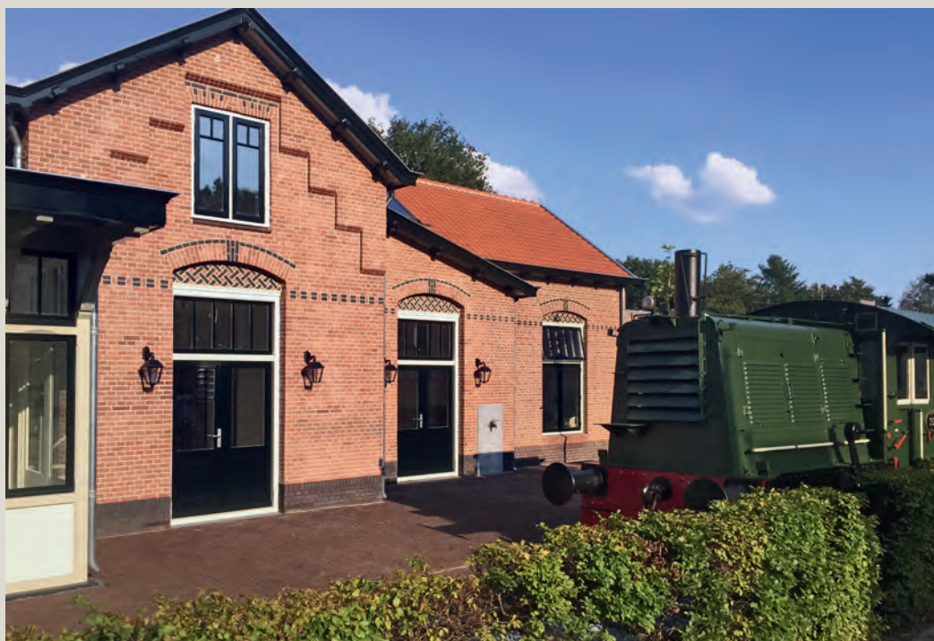
▲ Gasfabriek en goederenemplacement gezien vanaf het perron van station Zeist in 1961. FOTO J.G.C. VAN DE MEENE
